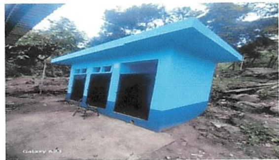
Foto 6: Mantenimiento de servicios sanitarios, limpieza y cambio de accesorios.
