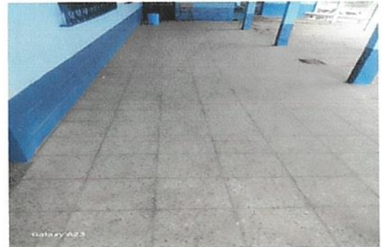
Foto 4: Cambio de piso de corredor
