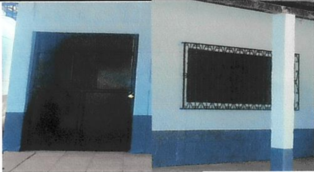
Foto1: Cambio de pintura de aulas, cocina puertas y balcones
