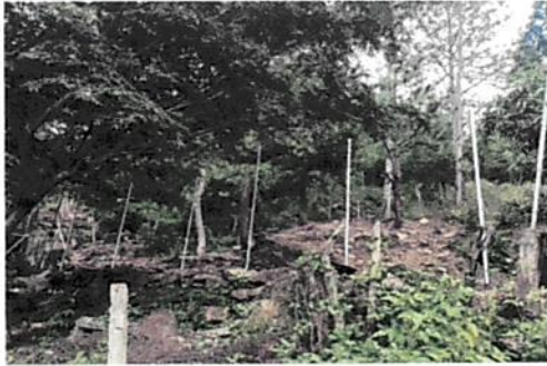
Foto 3: Reparación de malla de circulado del centro educativo.
